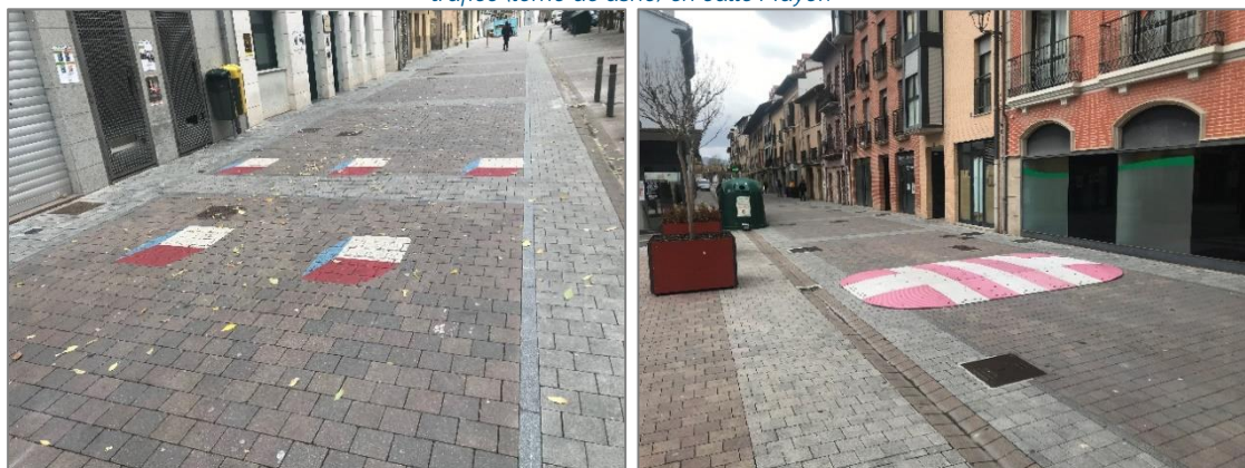
Gráfica 78. Señalización horizontal con efecto óptico para estimular la frenada de los conductores y elemento de calmado de tráfico (lomo de asno) en calle Mayor.
